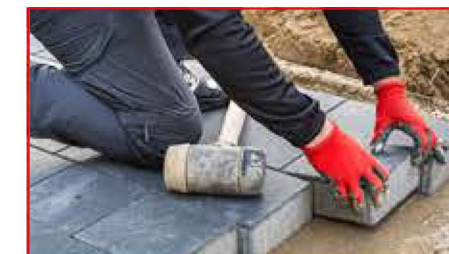
POSE DE PAVES
