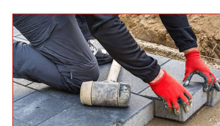
POSE DE PAVES
